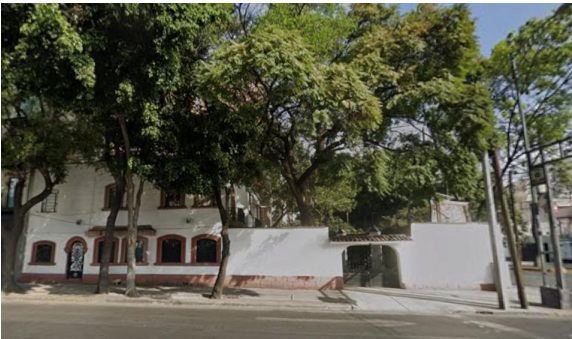
FACHADA AV. INDEPENDENCIA
